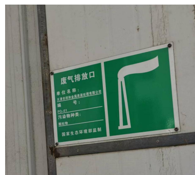
排气筒 P1 标识牌
