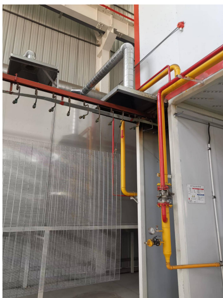
烘干炉废气收集集气罩
