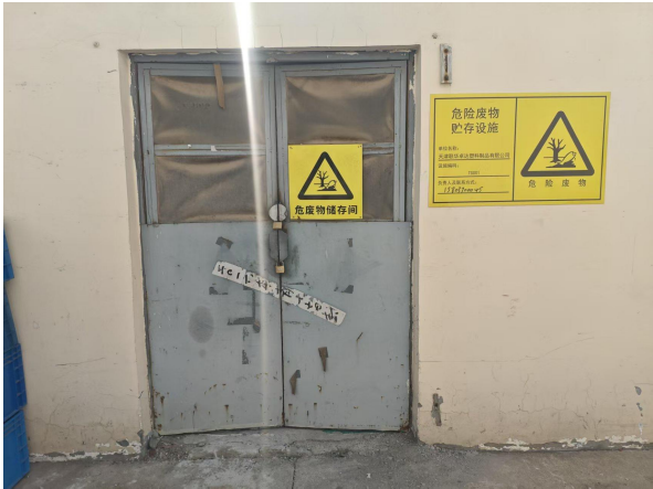
危废暂存间外部
